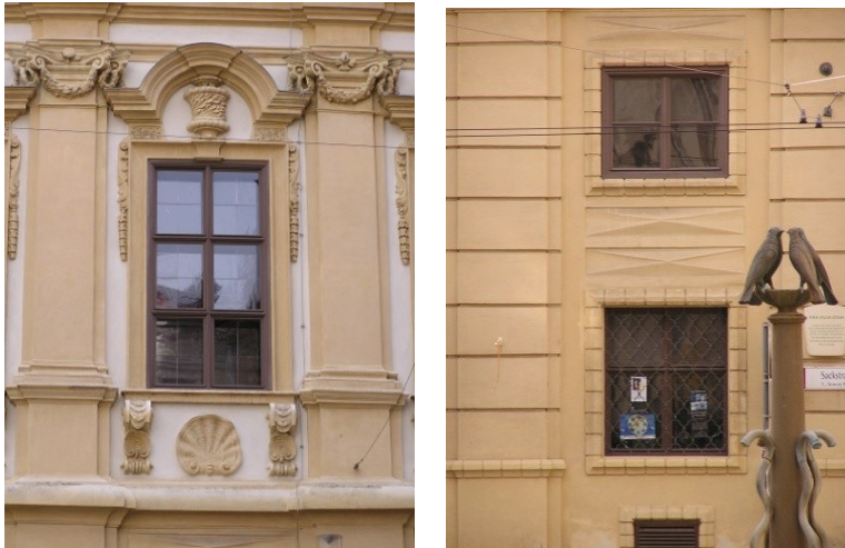
Abb. 4 und 5: Barockfenster, Graz, Palais Attems, Sackgasse
