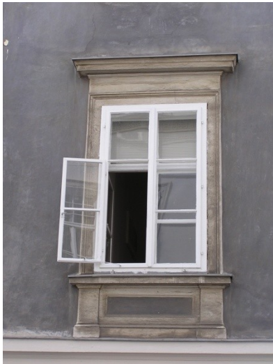
Abb. 6: Klassizistisches Fenster, mit Winterfenster, Graz, Ballhausgasse
