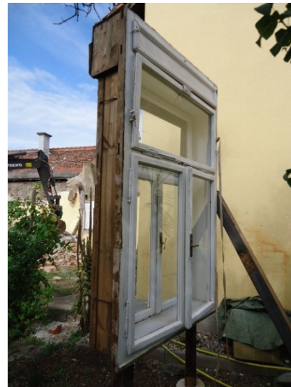
Abb. 10: ausgebautes Kastenfenster, Wiener Stock-Fenster
