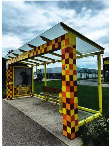
Abb. 1 Kleinarchitektur am Wegerand: Buswartehäuser, manchmal durchaus spektakulär, auf alle Fälle der Aufmerksamkeit wert. Fünfpark Asten, Oberösterreich
